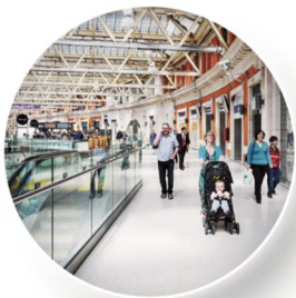
Zábradlí z bezpečnostního lepeného skla
